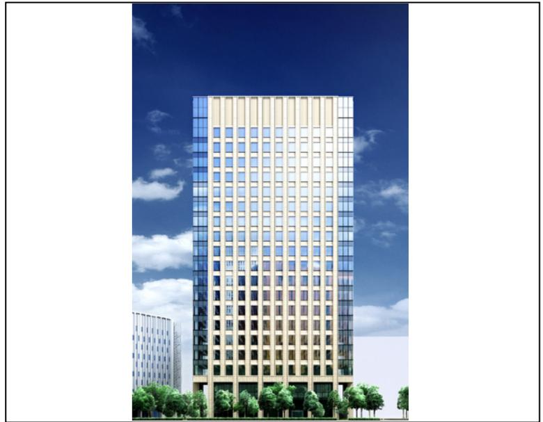
$$BEE = \frac{\text{建築物の環境品質 } Q}{\text{建築物の環境負荷 } L} = \frac{25 \times (Sq - 1)}{25 \times (5 - SLR)} = \frac{64}{30} = 2.1$$
